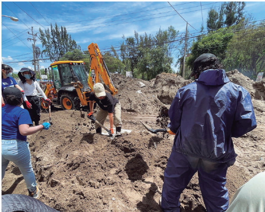
Ante lluvias en Arequipa, más de 40 voluntarios limpiaron y recuperaron viviendas afectadas.
